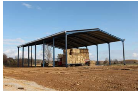
Edificación agrícola en Quintandiez
