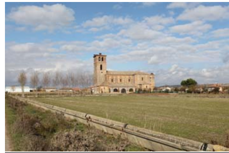
Canales de regadío
