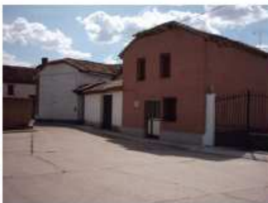
Construcciones del casco
